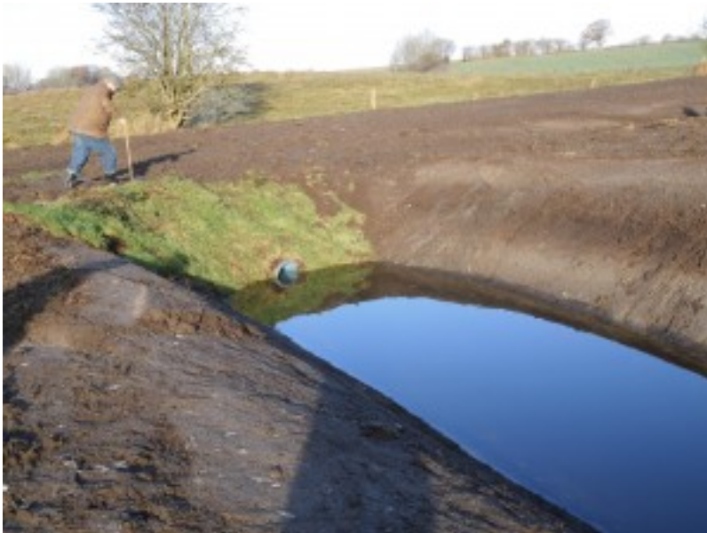
Der Verbandsvorsteher H. Münck bei der Vorabnahme „seines“ Sandfangs, hier das Detail -Langseeeinlauf- 2017
